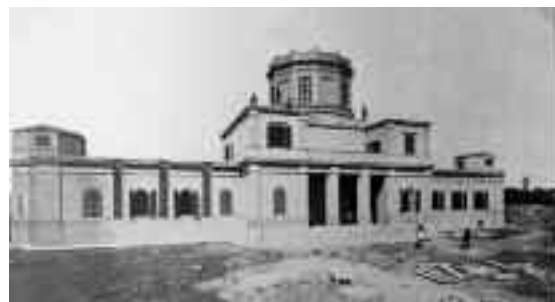
Fasi della costruzione dell'osservatorio astronomico di Firenze sulla collina di Arcetri, 1869 ca.
